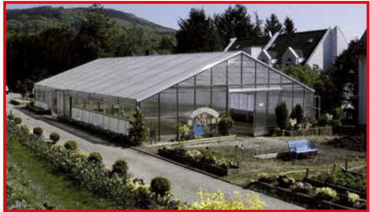
Dacheindeckung mit Stegdoppelplatten
