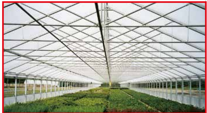
12 m-Haus, Stehwandhöhe 2,60 m, Rechteckbinder 120 x 60 x 6 mm, feuerverzinkt
