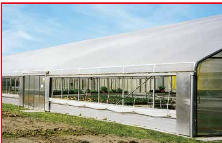
Seiteneingang mit Schiebetürelement 4 x 2,10 m und Abschlußblechen Tür 2 x 1,95 m mit 6 mm Polycarbonat-Stegdoppelplatten
