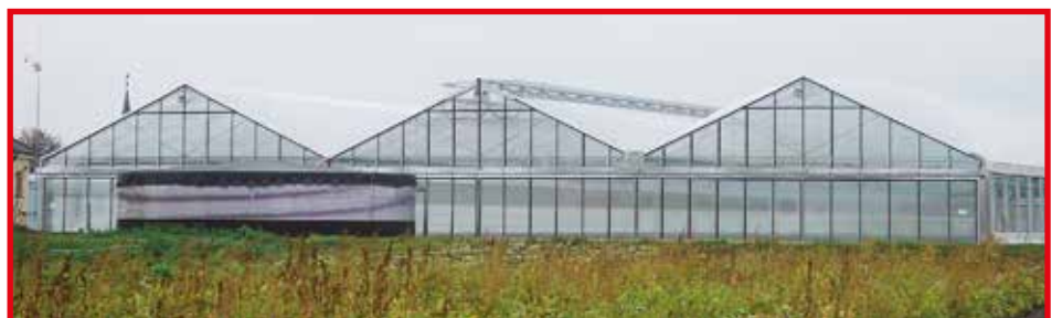
3-schiffige Ausführung 12 x 120 m mit 2 flügeliger Dachlüftung
