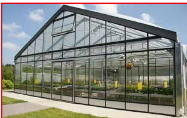
Giebeleindeckung mit Sicherheitsglas
