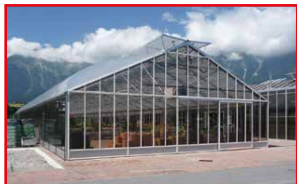
Colorverglasung mit weißen Abdeckleisten und 2-flügeliger Dachlüftung
