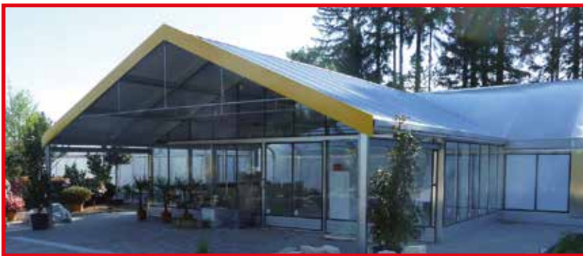
Vordach mit Giebelblende Eingangsbereich mit Schiebetüren in Glas und Alucobondsockel
