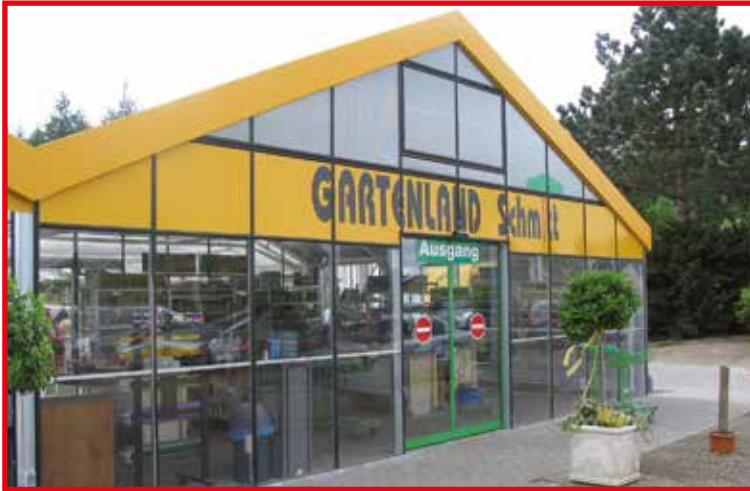
mit automatischer Schiebetür
