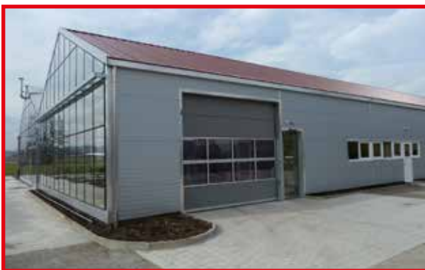
Mehrzweckhalle - Bedachung mit Sandwichplatten
