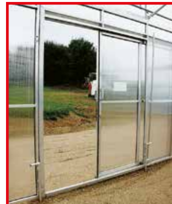
Schiebetür mit umlaufender Bürstendichtung, abschließbar
