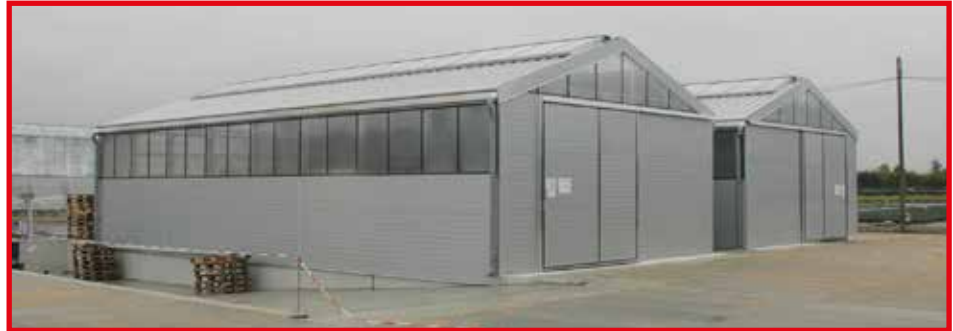
Topfalle mit Sandwicheindeckung und Dachlüftung
