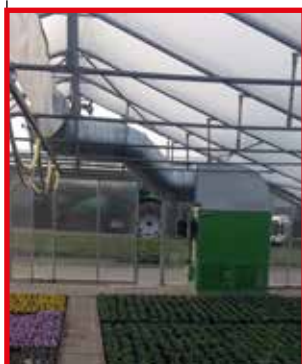
Einbaufertige Brennkammer mit Edelstahl-wärmetauscher
