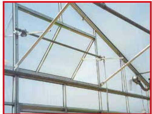
Giebellüftungsclappe mit Zahnstangen und Markisenantrieb
